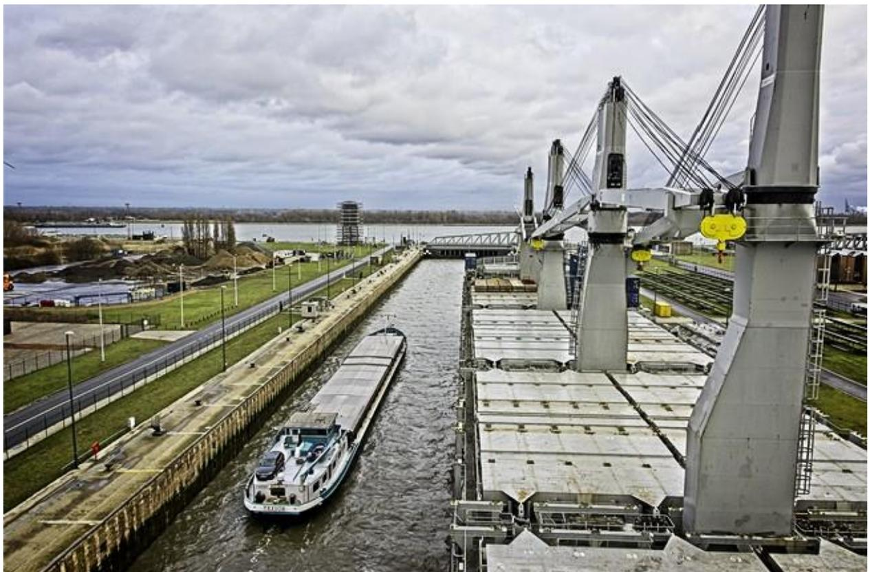
Dann schließt sich die Schleuse hinter uns und Wasser wird in das Schleusenbecken gepumpt, bis es auf derselben Höhe wie der Kanal auf der Antwerpen-Seite der Schleuse ist.
